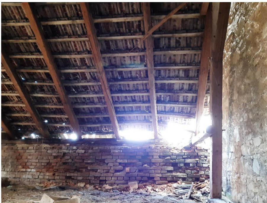
Pohled na severní roh u č.p. 15 zevnitř, zdivo zdegradováno dlouhodobým zatékáním, plné cihly poškozeny mrazem. U konstrukce krovu je rozpadlá pozednice, zhlaví krokví poškozené, úplně chybějící střešní krytina
