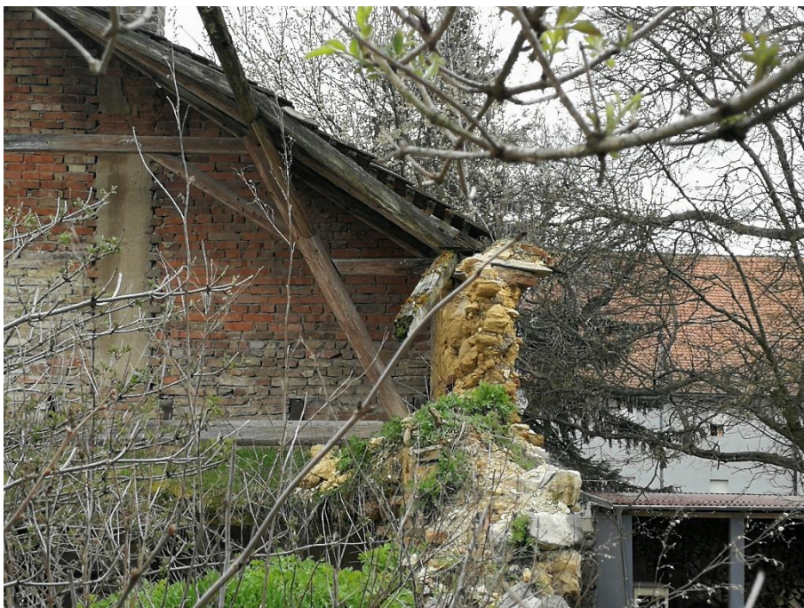
Pohled na půdní nadezdívku ukončenou přesazovanou římsou, zdivo je již za hranicí životnosti, při nepříznivých povětrnostních podmínkách hrozí její zřícení na sousední pozemek.
