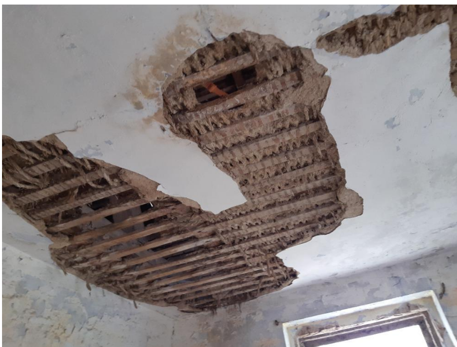
Pohled na dřevěné stropní konstrukce, úplně chybí horní záklop, podbití z latí s výpletem ze slámy s vápenohliněným vymazáním
