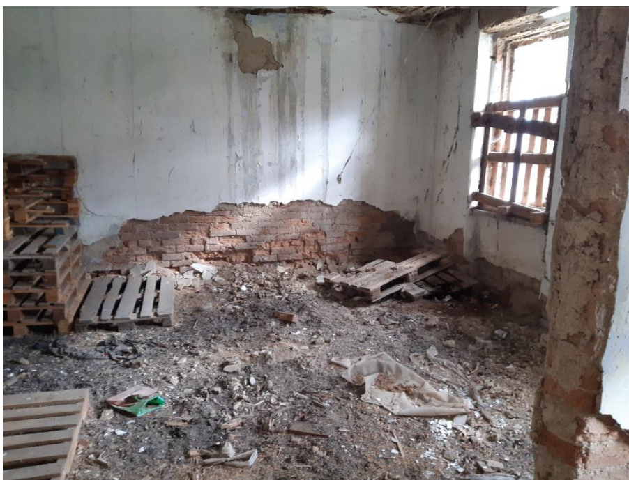
Pohled na štítovou stěnu směrem k č.p. 15, spodní část zdiva poškozena vlhkostí a mrazem
