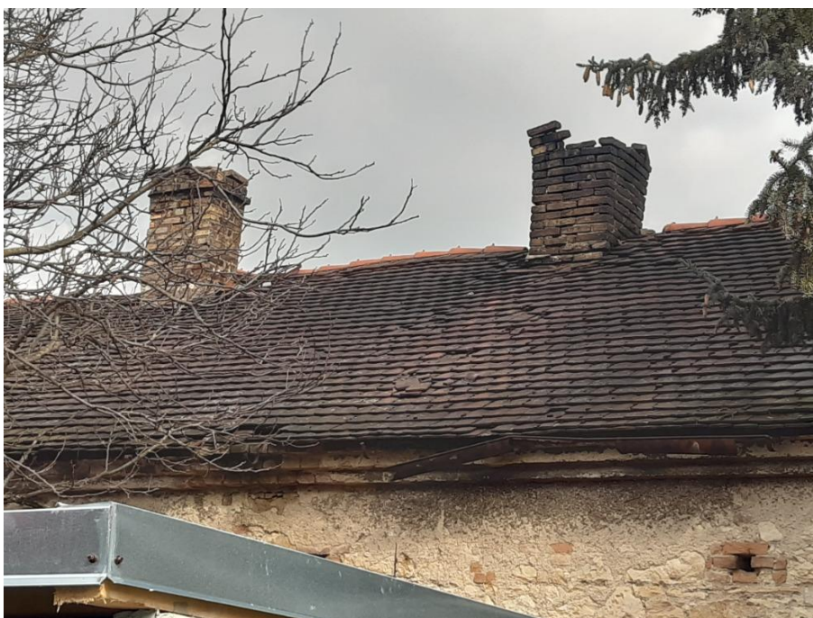
Pohled na rozpadající se komínovou hlavu, okolo komínu chybí oplechování, čímž dochází k uhnívání konstrukce krovu, na střeše jsou viditelné chybějící střešní tašky, podokapní žlaby jsou naprosto nefunkční
