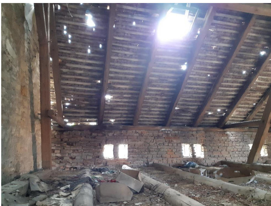
Pohled na dřevěnou střešní konstrukci shora – chybějící záklop, ve střeše chybějící krytina
